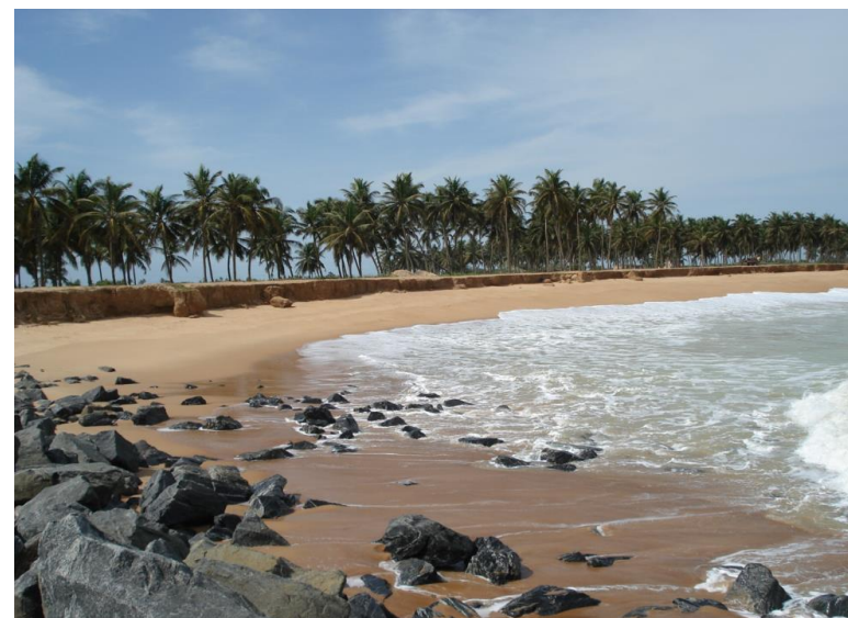
Photo 5 : côte en érosion après le dernier épi de Gumukopé
