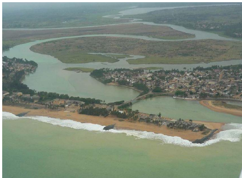
Photo 6 : Système de protection d'Aného
